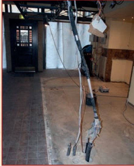
Während des Umbaus
